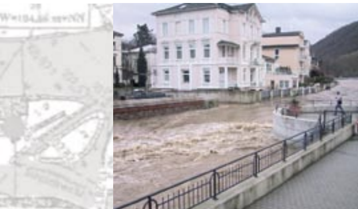
Das Tosbecken im Zulauf zum Mühlenteich am 03.01.2003
