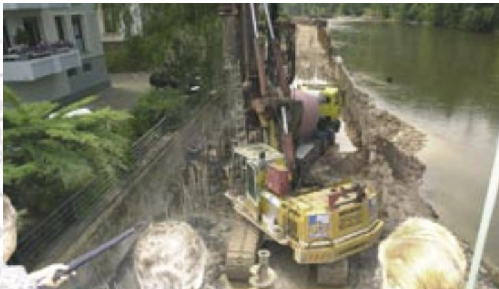
Herstellung der Großbohrpfähle
