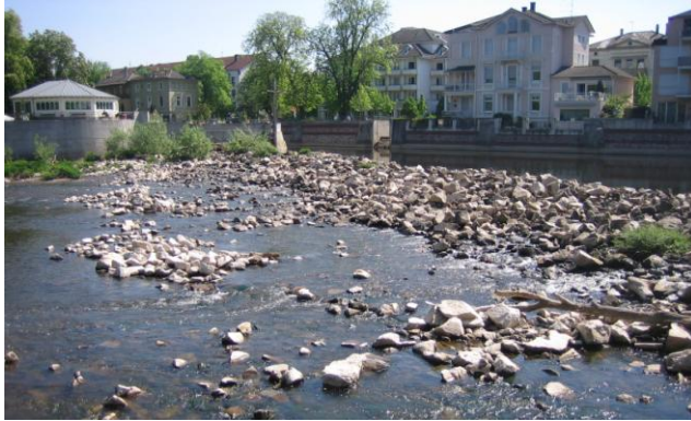
Zustand vor der Umgestaltung
