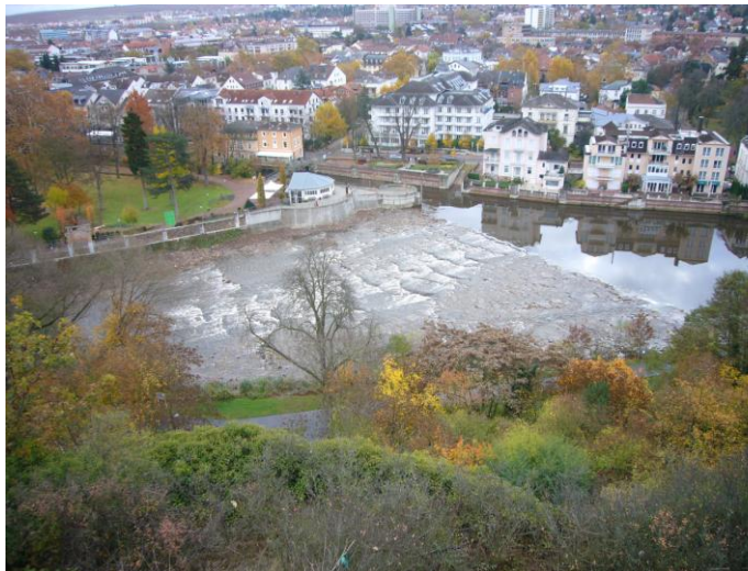
fertiggestellte Sohlengleite
