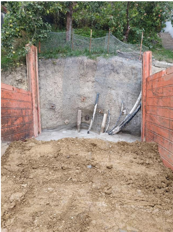
Bildunterzeile: verfülltes Stollenmundloch
